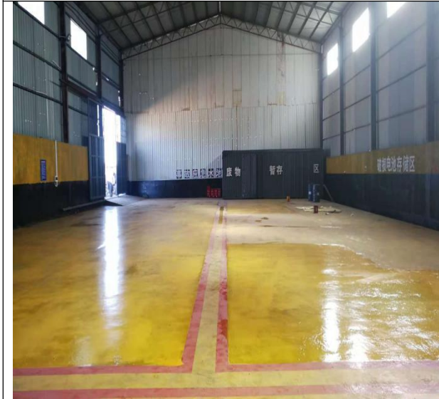
项目仓储区场地施工期防渗建设
