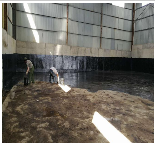
项目仓储区场地施工期防渗建设
