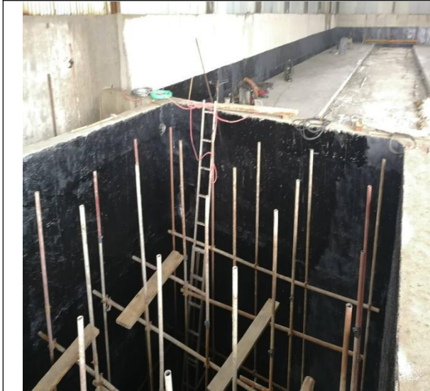
仓储区废液收集池兼事故应急池事故池防渗建设
